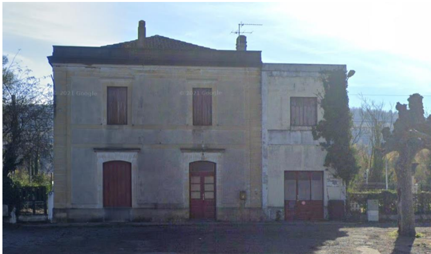
Photo du bâtiment voyageurs actuellement désaffecté
