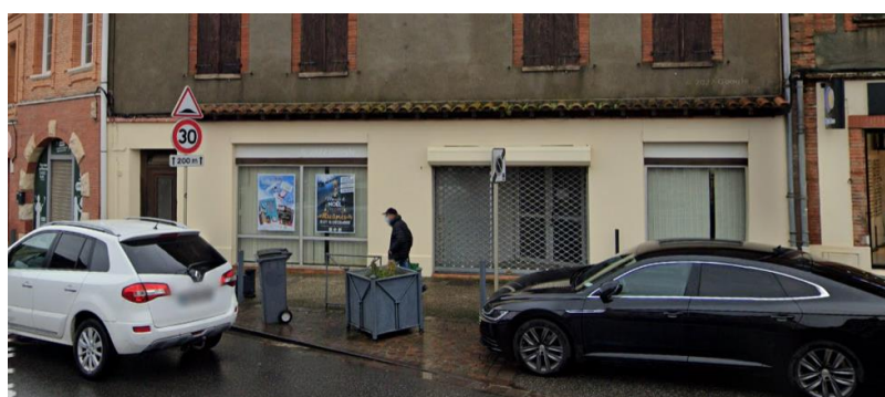
Photo du rez-de-chaussée de l'ancienne médiathèque depuis la place d'Armes
